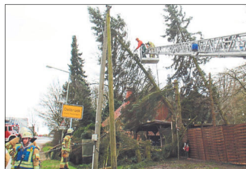
Die Feuerwehr in Delbrück musste Tannen fällen, die auf ein Haus zu stürzen drohten. Foto: Axel Langer
