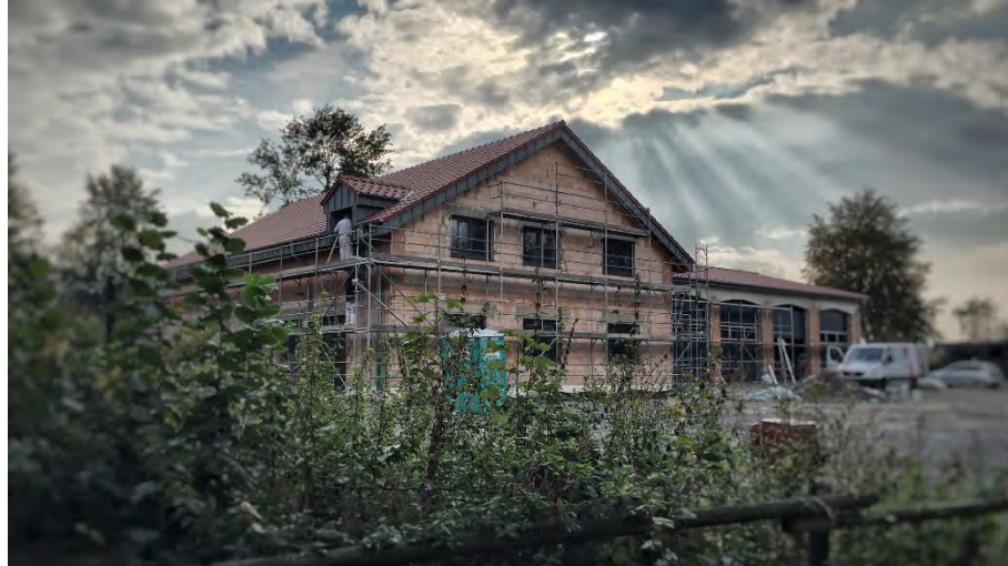
Putzarbeiten am eingerüsteten Begegnungszentrum (Foto: Markus Krick).
