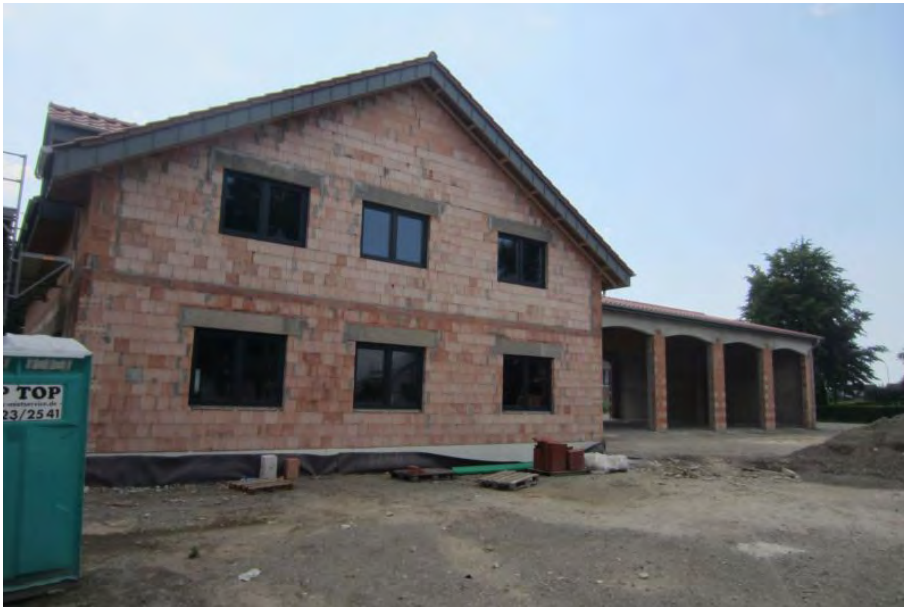
Der Einbau der Fenster ist erfolgt (Foto: Verein Begegnungsstätte Verne).
