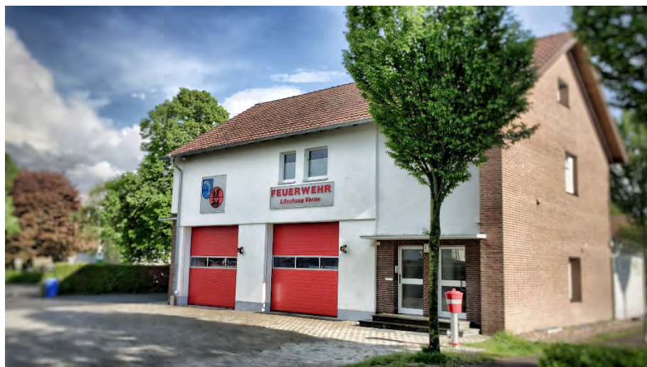
Das runderneuerte Feuerwehrgerätehaus (Foto: Markus Krick).
